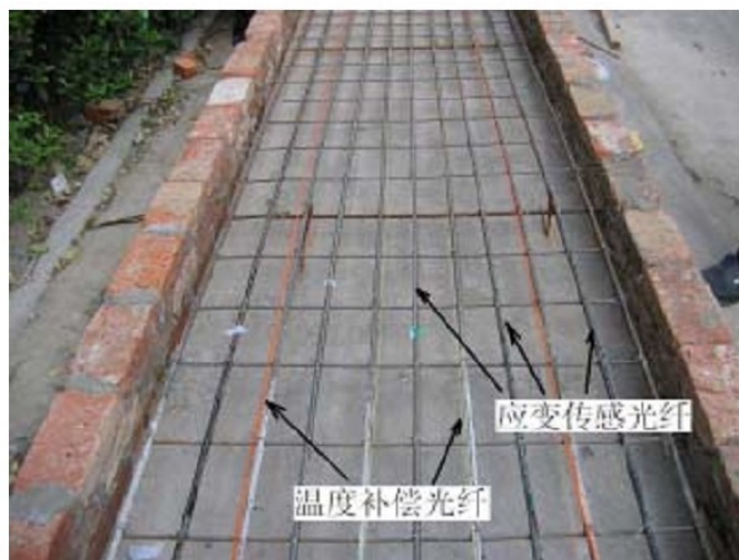
图 11 连续配筋混凝土路面检测示意图
