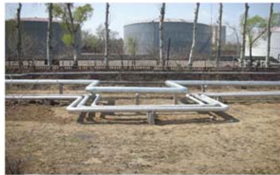
管道、线缆同程敷设
